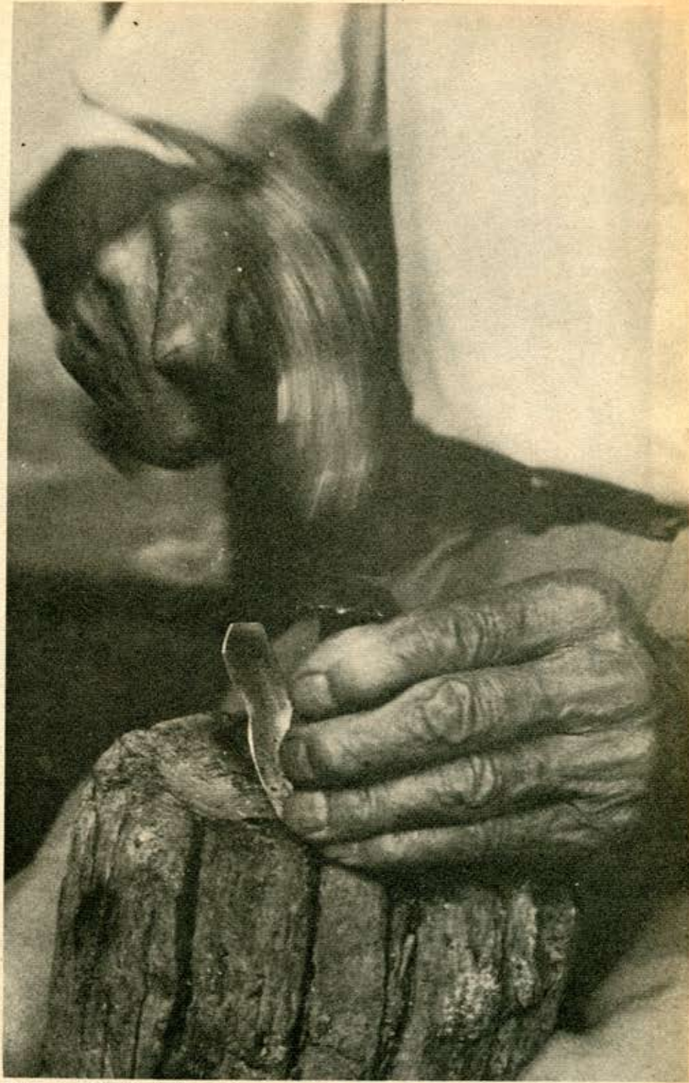
Pedro Fonteñez haciendo un exvoto: trabaja con el "embutidor" para dar forma cóncava a la pieza.
