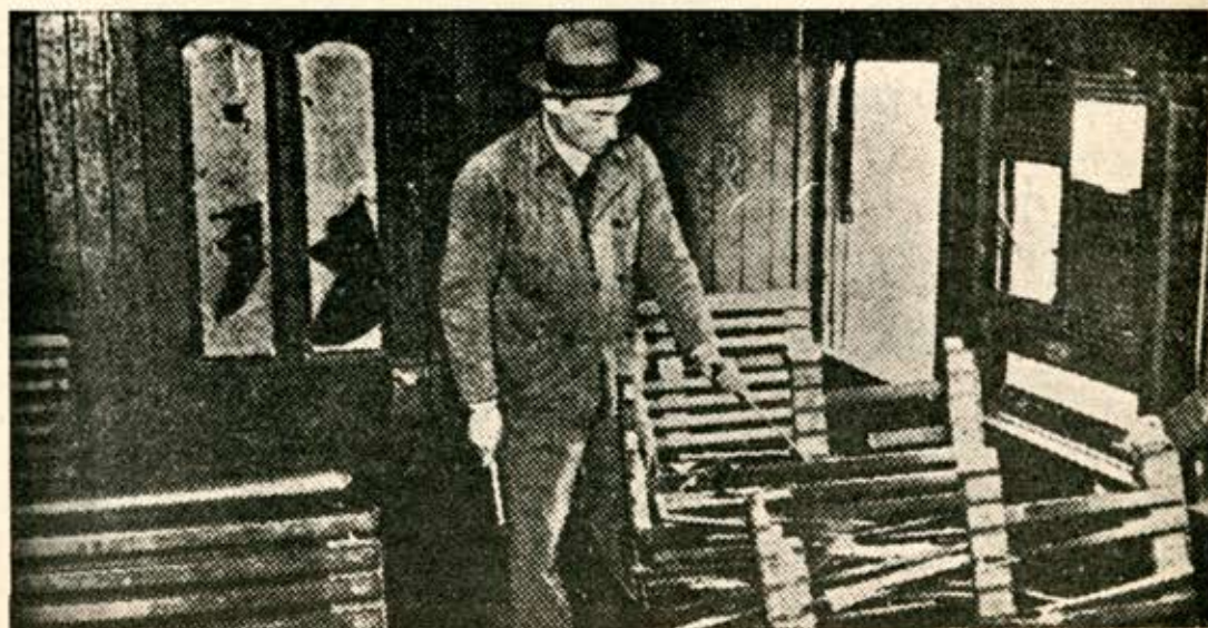
Este vagón de 2a. clase de las líneas urbanas del Ferrocarril Sud sufrió la rotura de todos sus vidrios, como consecuencias de la pedrea
