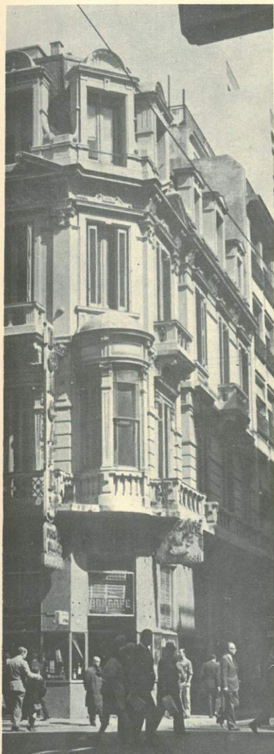
Edificio de Florida y Tucumán, en cuyo tercer piso funcionó la redacción de Martín Fierro
