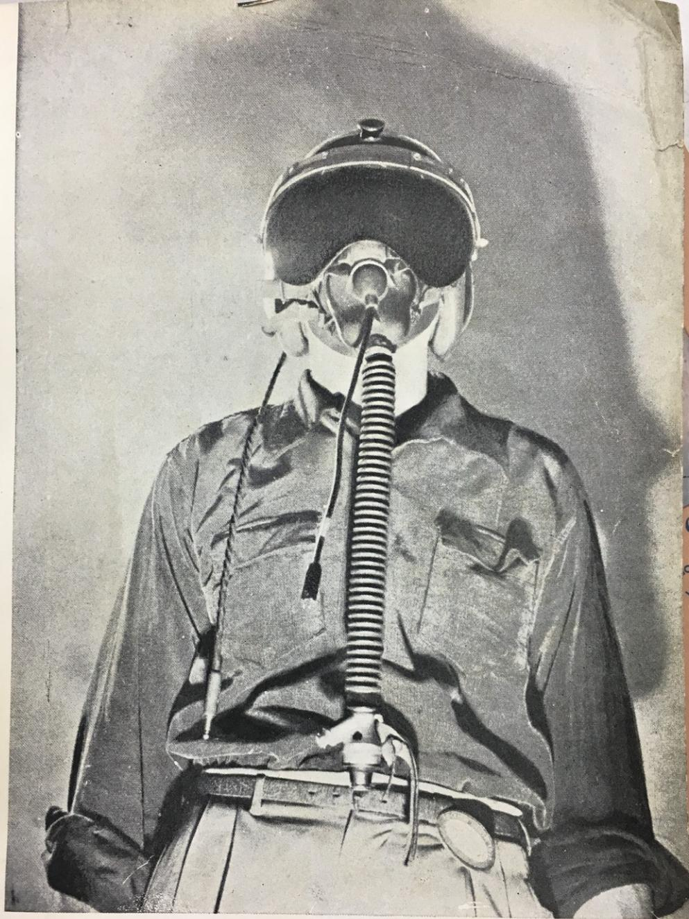
*Esta máscara mejorada para pilotos a chorro incluye un visor oscuro para evitar el brillo enceguecedor de las grandes alturas. Obsérvese el cable para las comunicaciones radiales y el tubo de oxígeno que van conectados al sistema general del avión.*
