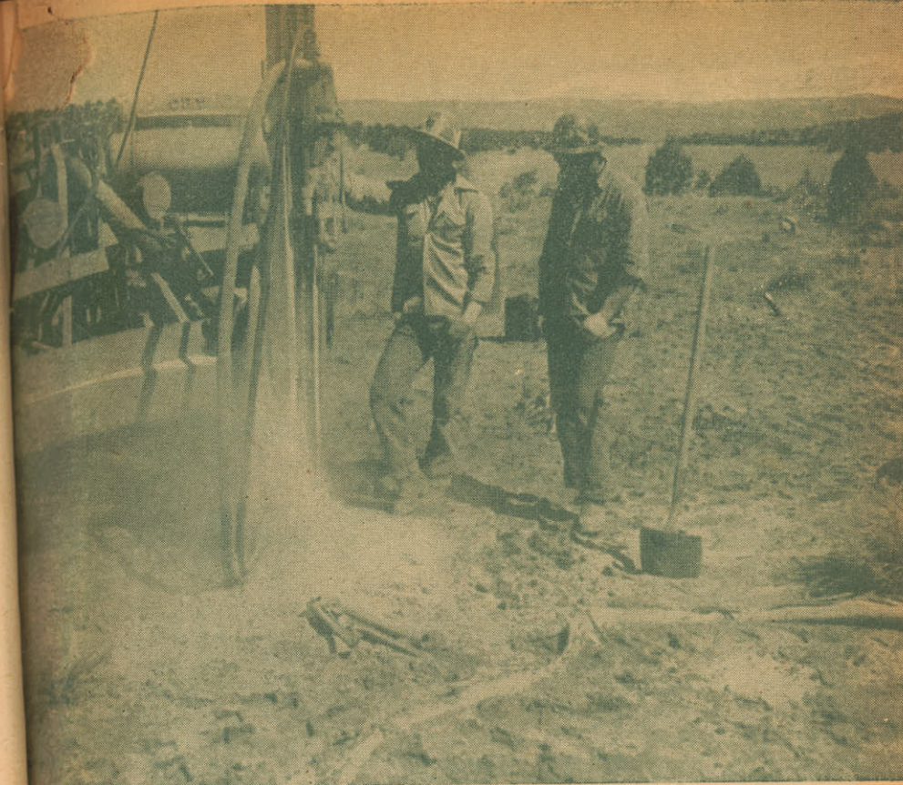
PERFORADORA RODANTE. — El nuevo tipo de perforadora que ilustra la fotografía ha sido desarrollado especialmente para la búsqueda de Uranio.
