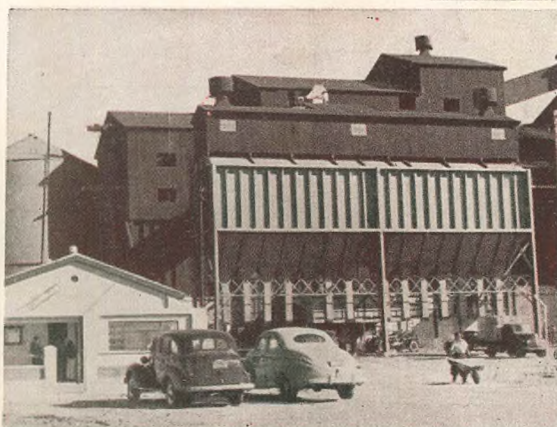
Mediante este sistema se procede al lavado del monóxido de carbono. Esta es una vista del lavador y eductores.
