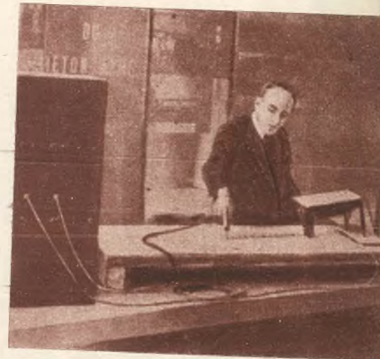
Un oscilógrafo mide en un bloque de concreto la velocidad del sonido. De allí podrán deducirse sus características mecánicas.
