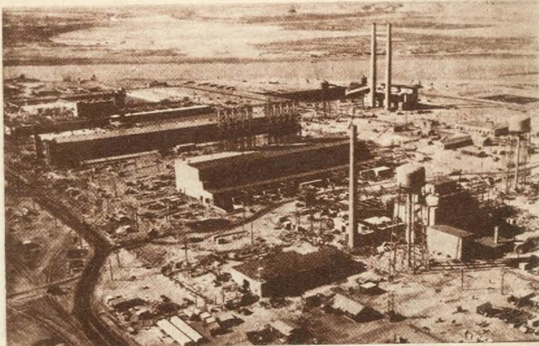
Una vista parcial de las instalaciones de Hanford, en EE. UU., donde se produce plutonio por irradiación de uranio natural con neutrones, en reactores especialmente construidos para ese objeto.
