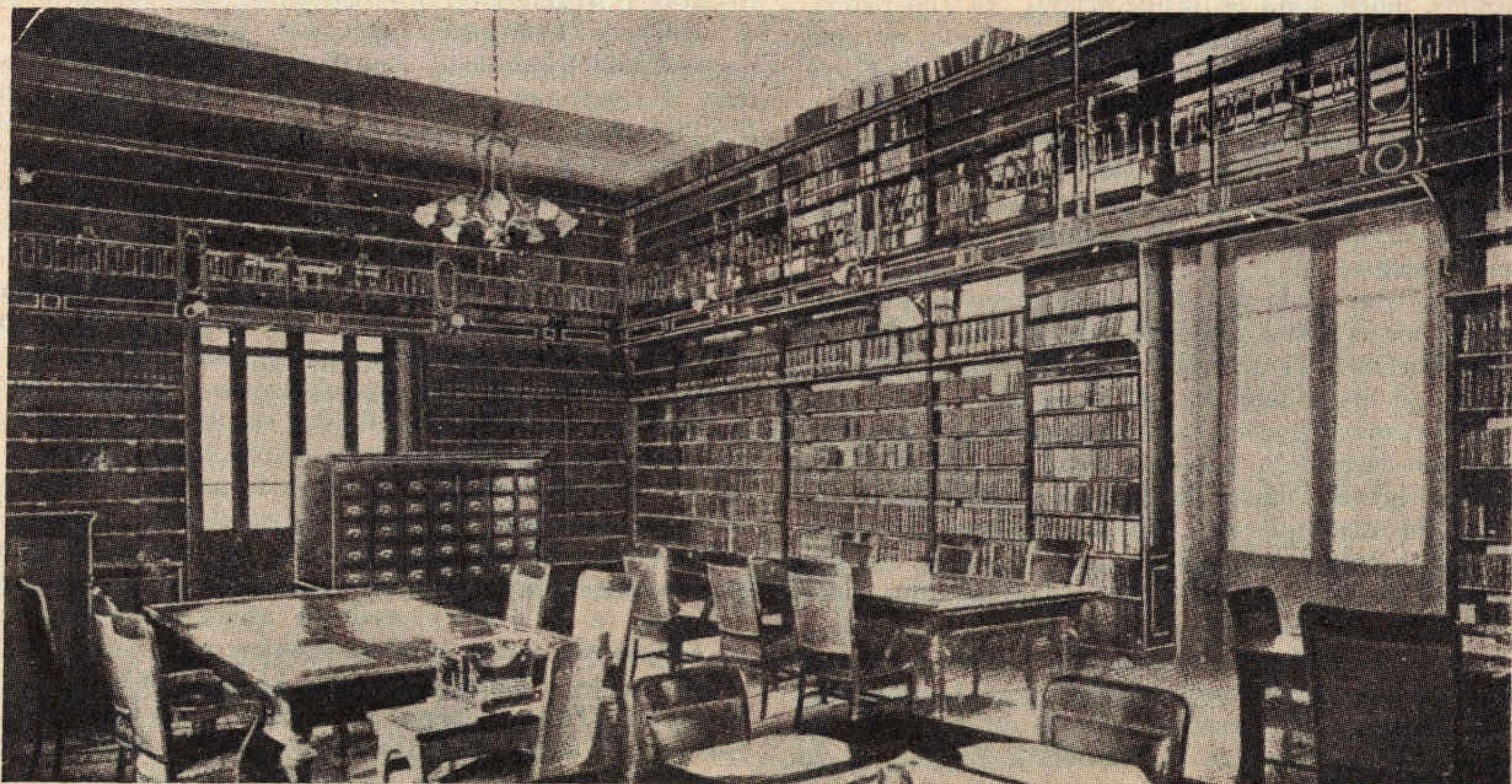
Aspecto parcial de la biblioteca
