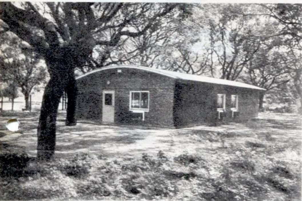
Edificio del Centro de Coordinación del programa en Buenos Aires.
