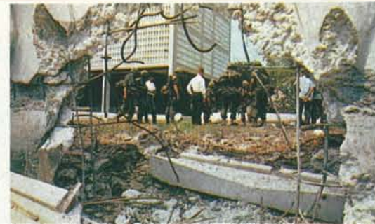
Por un boquete abierto con dinamita en las paredes de cemento entraron los guerrilleros a la embajada.
