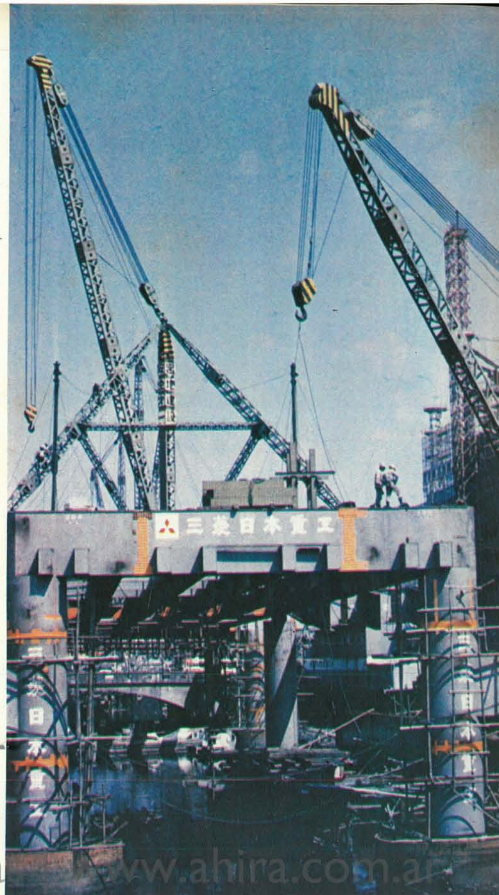
Solución audaz para el tránsito intenso: las estructuras metálicas soportarán una autopista sobre agua.
