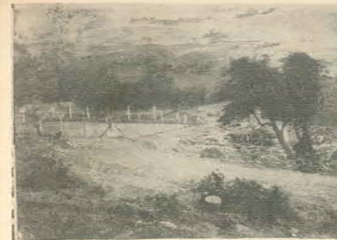
El solar, durante la construcción de las instalaciones del Polígono.
