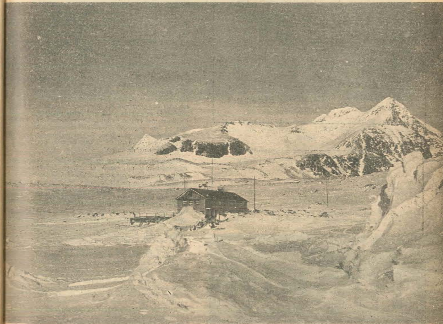
La casa de la Base B. Esperanza con el Pirámide y Monte Flora por detrás y el mar helado por delante.
