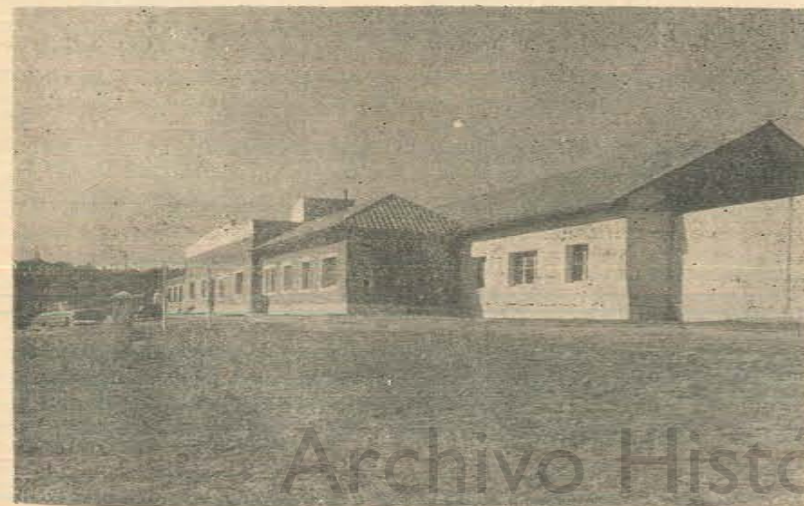
Vista panorámica del frente del nuevo edificio, cuyos extremos no han sido terminados aún.
