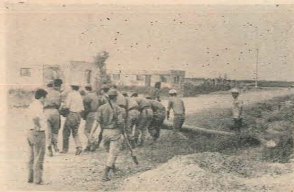
1. - Soldados del R. 29 de Infantería de Monte realizando trabajos para la instalación de la red de suministro de energía eléctrica.
