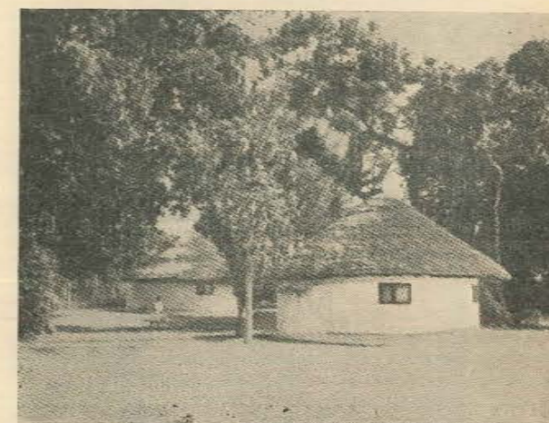
Típicas viviendas destinadas a los cazadores en Camp Zinave. Los deportistas pueden encontrar en ellas todo lo necesario para una confortable estadía.
