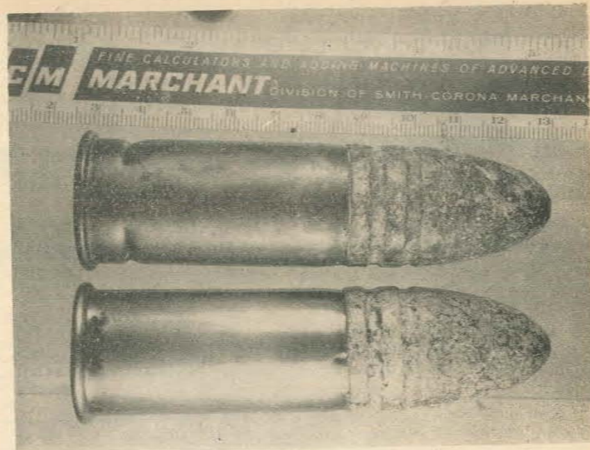
Cartuchos utilizados por la ametralladora Gatling, arma de disparo múltiple que se utilizó en Estados Unidos durante la Guerra Civil. Son del calibre de 1 pulgada con fulminante interno.
