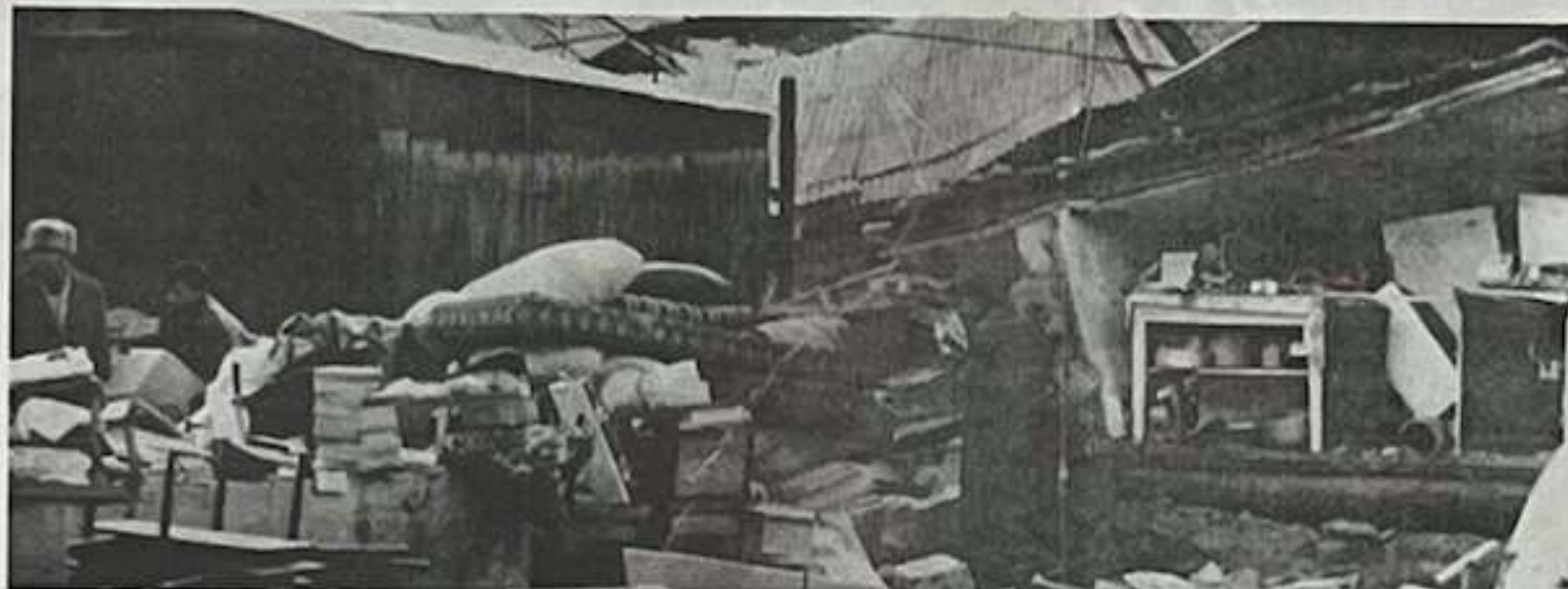
La devastación producida por el terremoto en Armenia no atenuó la disputa étnica
