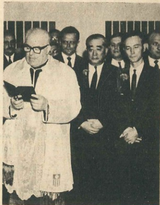
Bendición para la casa nueva.
