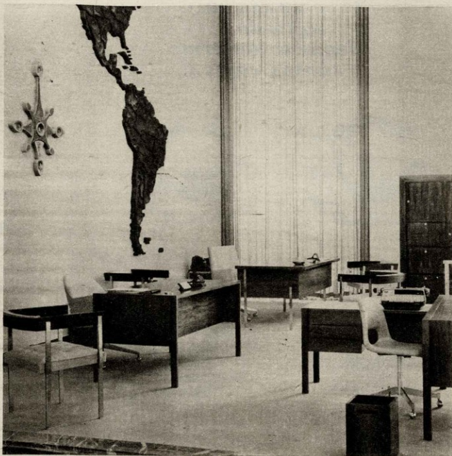
The First National Bank of Boston - Sucursal Flores / El proyecto y dirección de obra estuvo a cargo de los arquitectos Dodds y Cattaneo.
