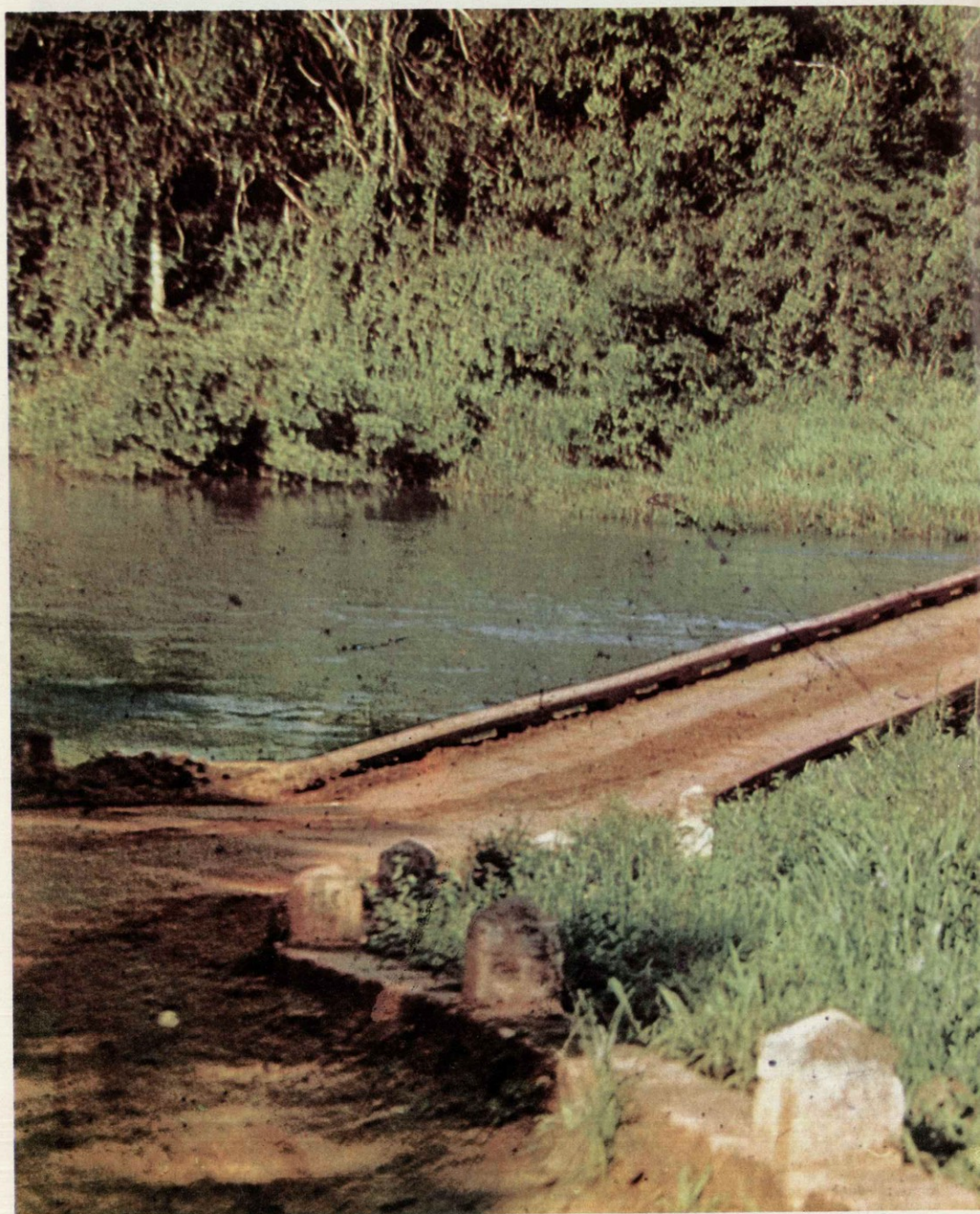
El puente sobre un río misionero: Quizá más importante que la misma ruta, para sacudir la soledad.
