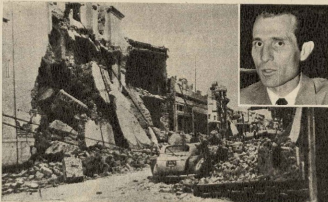
Giuliani, hoy, y la calle Rivadavia después del sismo.
