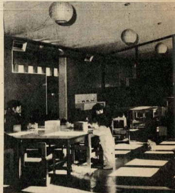
Guarderías: Impacto de Acindar.
