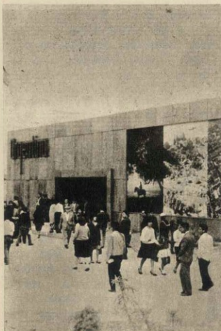
Pabellón argentino: Se lo desmontó para entrar nuevas maquinarias.
