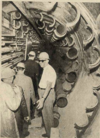
Para colocar 250 metros de túnel subfluvial hubo que dragar 150.000 metros cúbicos de toscas y cavar una fosa en el lecho del Riachuelo.
