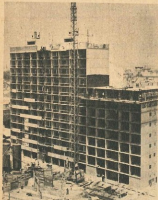
Para la construcción de cada piso emplearon tres días y medio.
