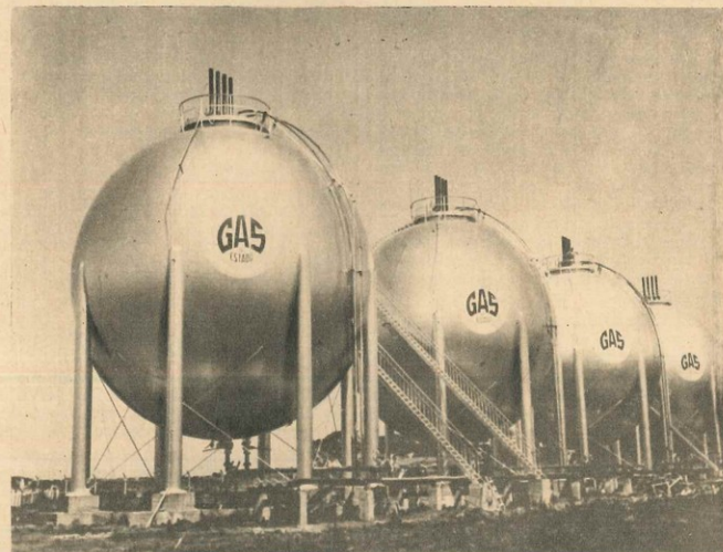
En la planta de General Belgrano, el gas licuado espera en grandes depósitos ser envasado en los cilindros y garrafas de 45 y 10 kilos.
