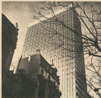
Aire acondicionado en el rascacielos de Santa Fe y Suipacha.
