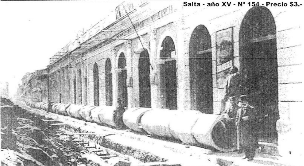
Instalación de cloacas Alberdi y Alvarado, año de 1920. Foto archivo revista Claves.
