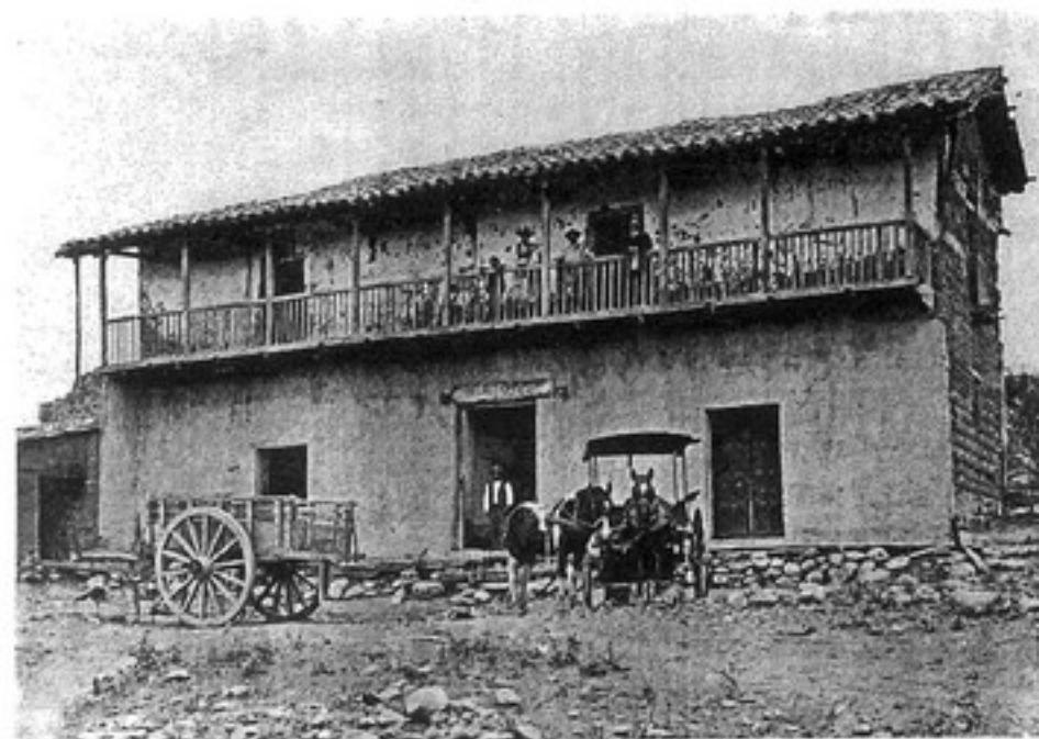
Trabajos de remodelación en el Fuerte Histórico de Cobos. 1925. Archivo y Biblioteca Históricas de Salta.
