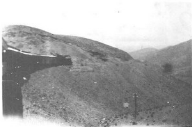
Volviendo de San Antonio de los Cobres para entrar al Viaducto. 10 de julio de 1935.
