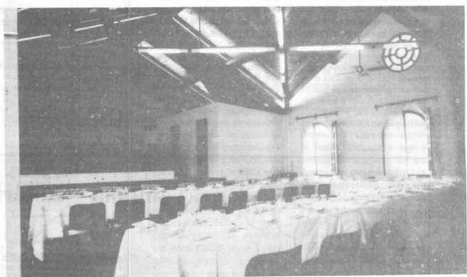
DETALLE DEL CIELORRASO Y SALON DEL SEGUNDO PISO
