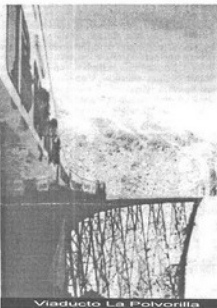
Viaducto La Polvorilla
