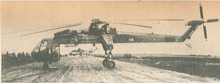
CH-54 (Grúa voladora). Función: Transporte de equipos pesados. Carga: Cuatro hombres, y 9.060 kilos. Costo: 2.000.000 U$S.
