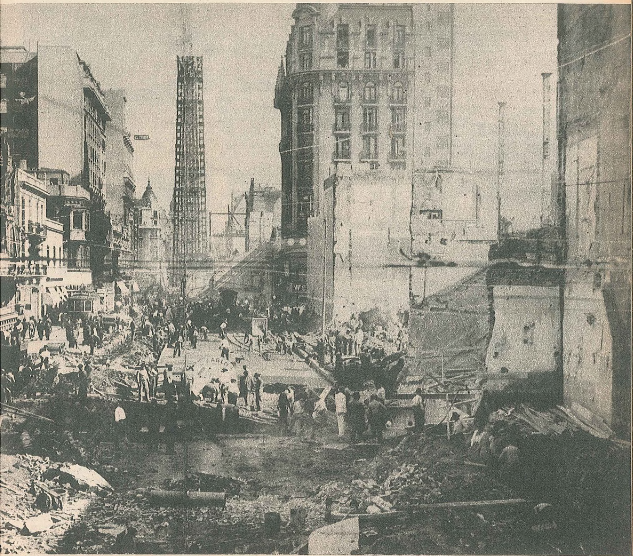
Remodelación de la calle Corrientes en 1936.
