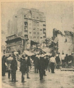
Derrumbe: ¿Fatalidad?.. Impunidad. (Montes de Oca.)
