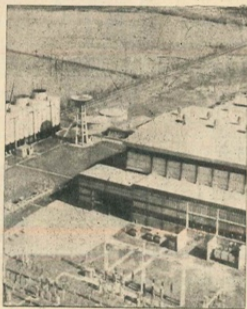
Central térmica: 30.000 Kw.
