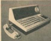
**CONMUTADOR CROSSBAR PENTAconta.** El más avanzado conmutador telefónico automático.
