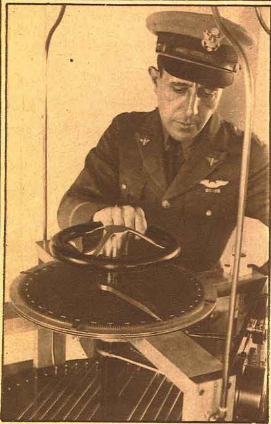
Teniente Walter B. Hough, miembro de la oficina de radio de Mitchell Field, Nueva York, en el momento de señalar la ruta de un aviator por medio del goniómetro. La flecha indica, como se sabe, la dirección en la cual es recibida la señal.
