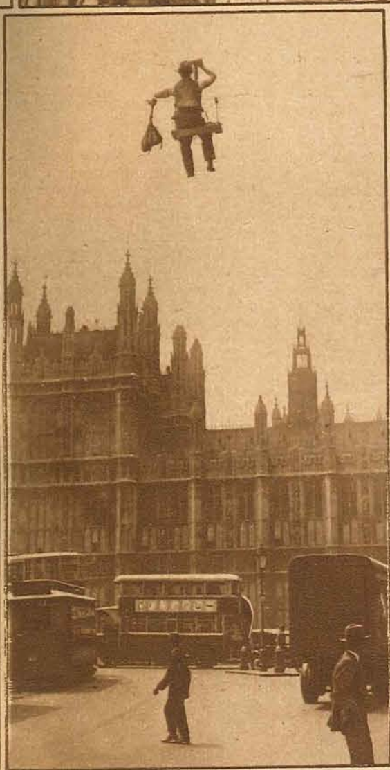
Un obrero reparando los cables de luz eléctrica a gran altura, sobre la calzada, en Bridge Street, Westminster.
