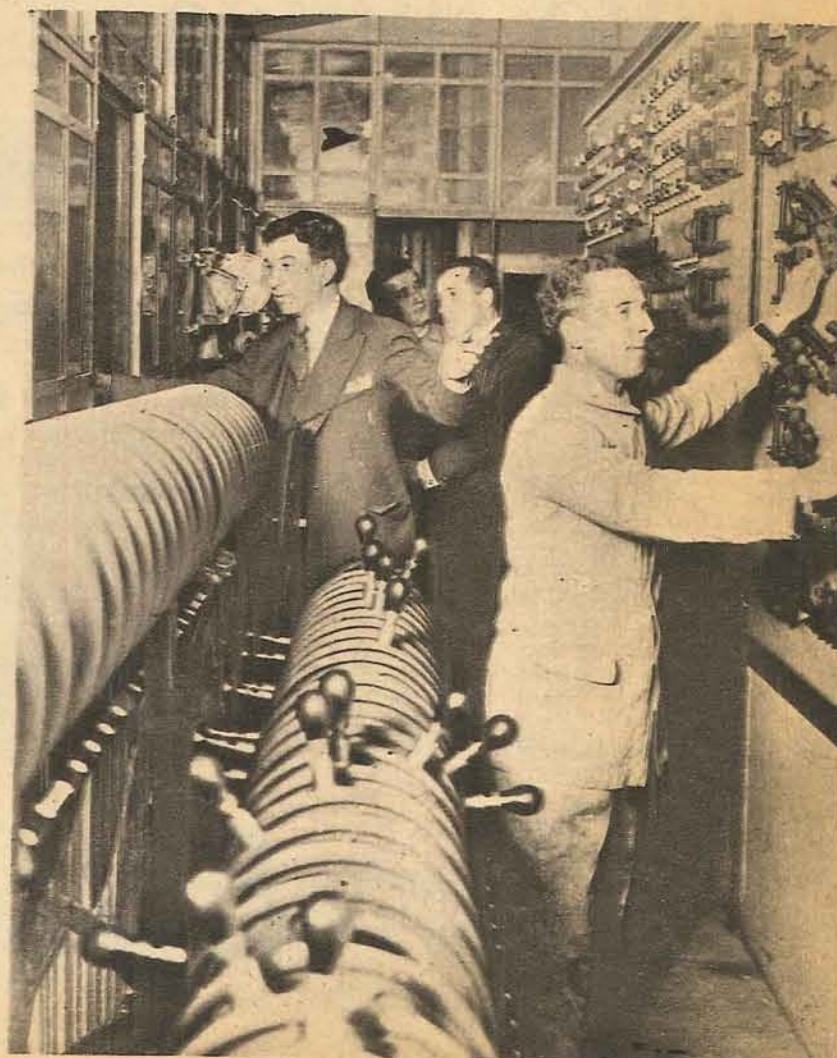
Esto que parece el comando de un transatlántico o el complicado mecanismo de alguna usina, no es más que el conjunto de llaves que regula el juego de luces del Teatro Colón. Ese conjunto de llaves y palancas requiere, como es fácil presumir, una dedicación minuciosa y una preocupación excluyente de toda otra. Armando Saladino, jefe de electricistas, es el que tiene la dirección general de este mecanismo, cuyo funcionamiento está sintetizado en 150 llaves y 120 resistencias
