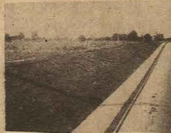
Una vista que muestra cómo deben mantenerse los taludes laterales a fin de embellecer los caminos y evitar desmoronamientos
