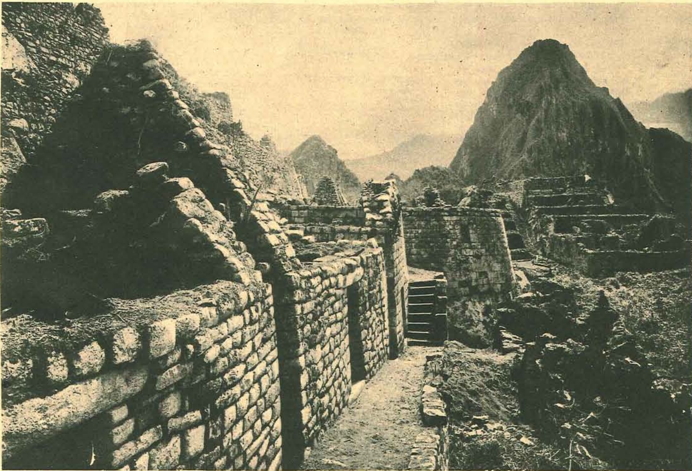
Detalle de las construcciones, cubos y andenes de la ciudadela, cerca de Ollantaytambo
