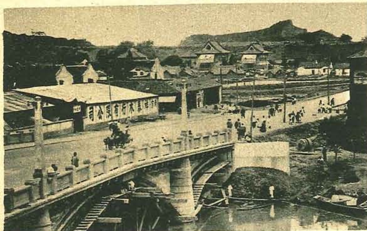
Síntomas de modernización en Nankin, la capital de China: Un puente moderno
