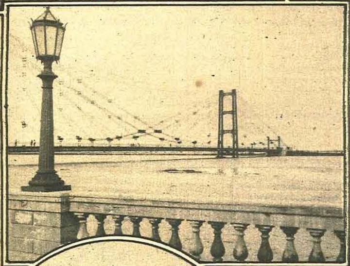
El puente colgante sobre la laguna Setubal, Santa Fe.
