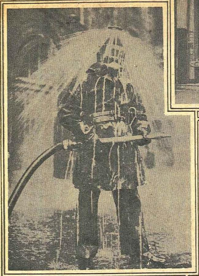
El último progreso de la técnica en materia de equipo de incendios es el casco-surtidor adoptado por los cuerpos de bomberos alemanes. Un caño especial le une a la manga y mediante un simple movimiento de palanca el bombero puede soltar el agua y aislarse así eficazmente de las llamas
