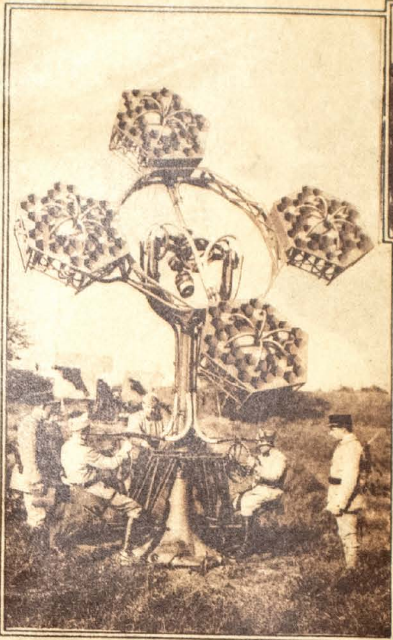
El "telesímetro" ideado por el francés Perrin, constituye el más valioso de los auxiliares que señalan un avión a la artillería especial de defensa.
