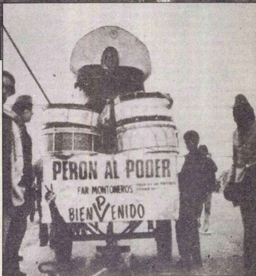
Bombos en la autopista, junto al cruce con el Camino de Cintura.
