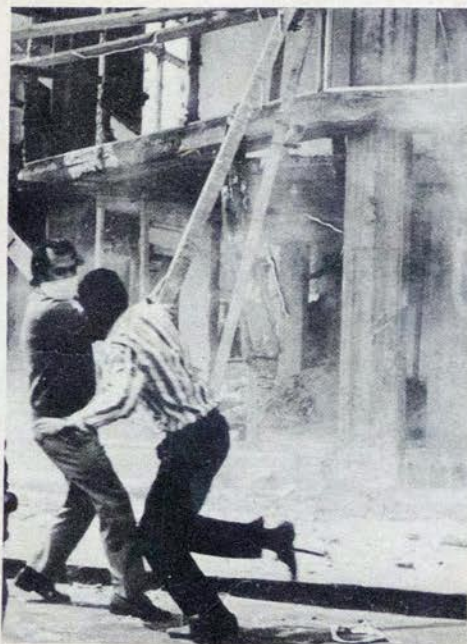
Calle Entre Ríos: Destruir el andamiaje
