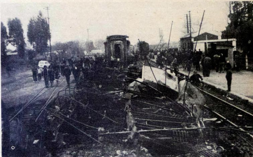
Empalme Graneros: Los estragos del fuego
