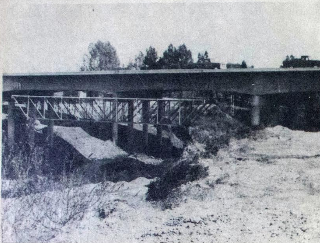
Autopista : Puente sobre el Carcarañá
