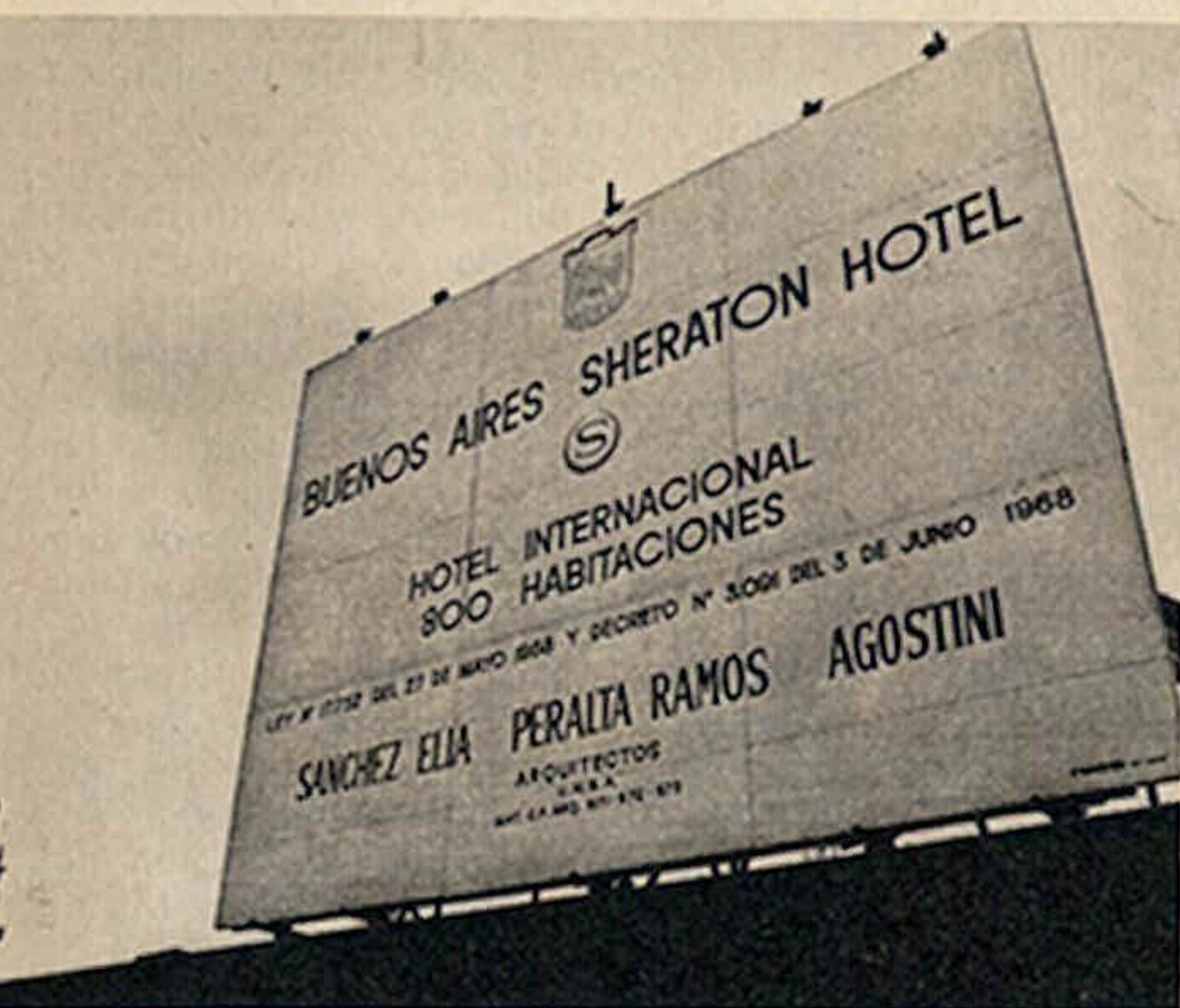
A todo vapor se trabaja en el Sheraton: tendrá 800 habitaciones y salas de congresos aptas para capturar dólares.
